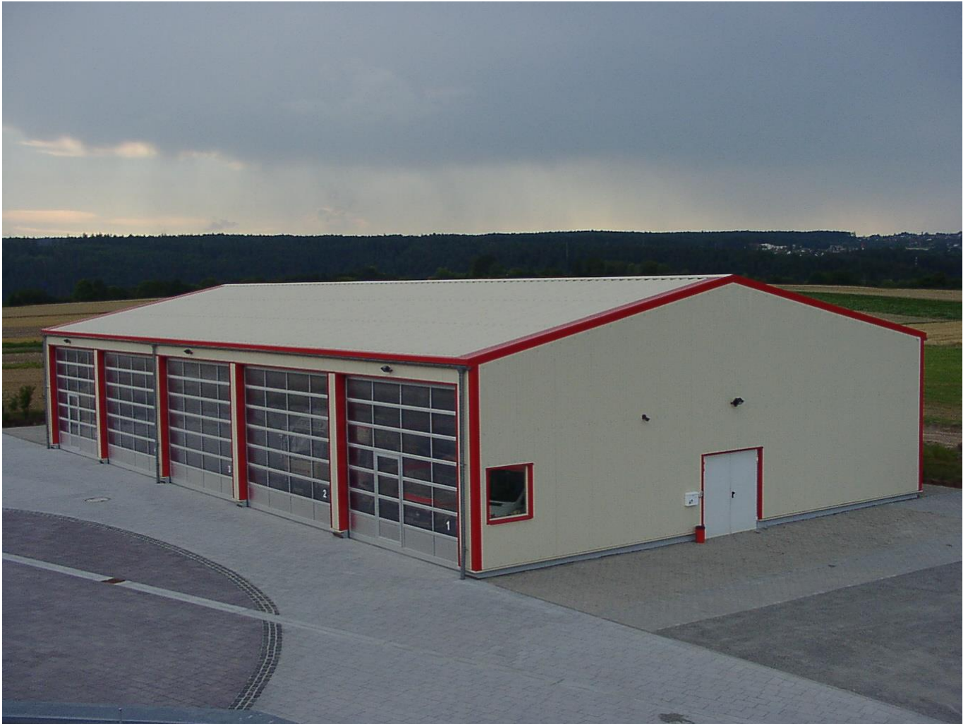
Unsere Fahrzeughalle als 1. Bauabschnitt
